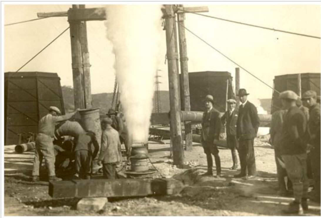
Manovre per l'imbrigliamento di un soffione –fotogallery ENEL – Larderello (PI)
